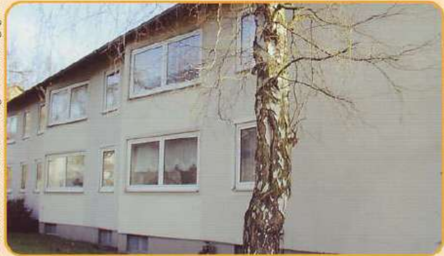
Zustand vor Sanierung
